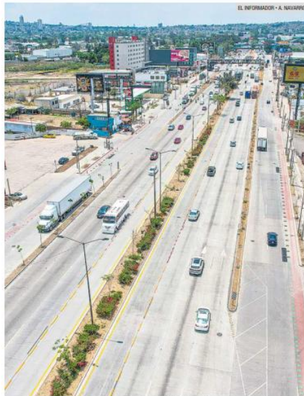
INFRAESTRUCTURA. La Línea 5 y la rehabilitación de Carretera a Chapala son obras que perdurarán tras la Copa del Mundo.
