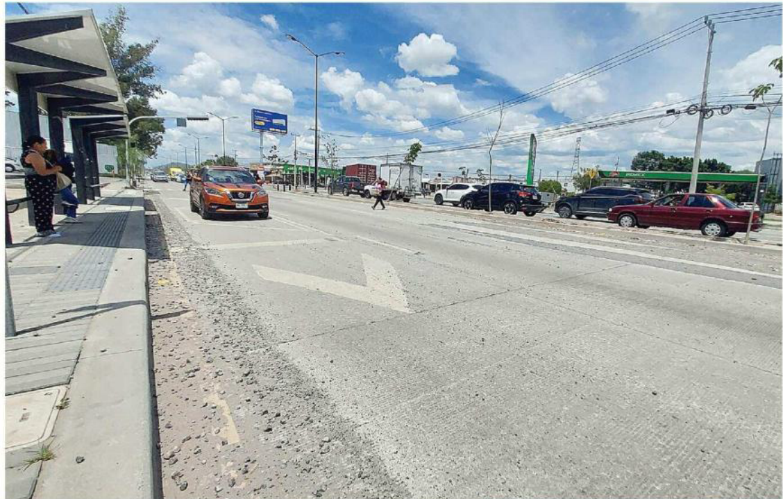
■ Hace apenas seis meses fue reabierto la Avenida Camino Real a Colima, tras las obras de rehabilitación y ya se registraron “encharcamientos”
