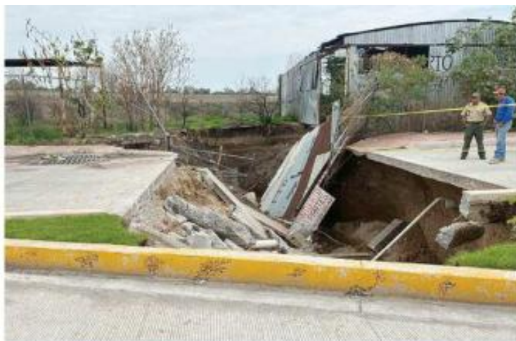
En San Juan de los Lagos, surgió un socavón sobre Bulevar Ramón Martín Huerta.
