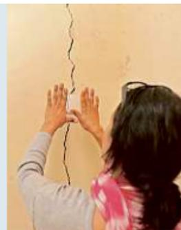
Las grietas longitudinales tienen al menos 2.5 centímetros de abertura.
