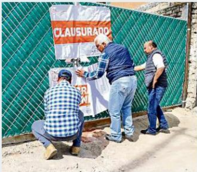
■ La construcción de un edificio, que cuenta con licencia municipal, tiene sellos tanto de clausura como de suspensión.
