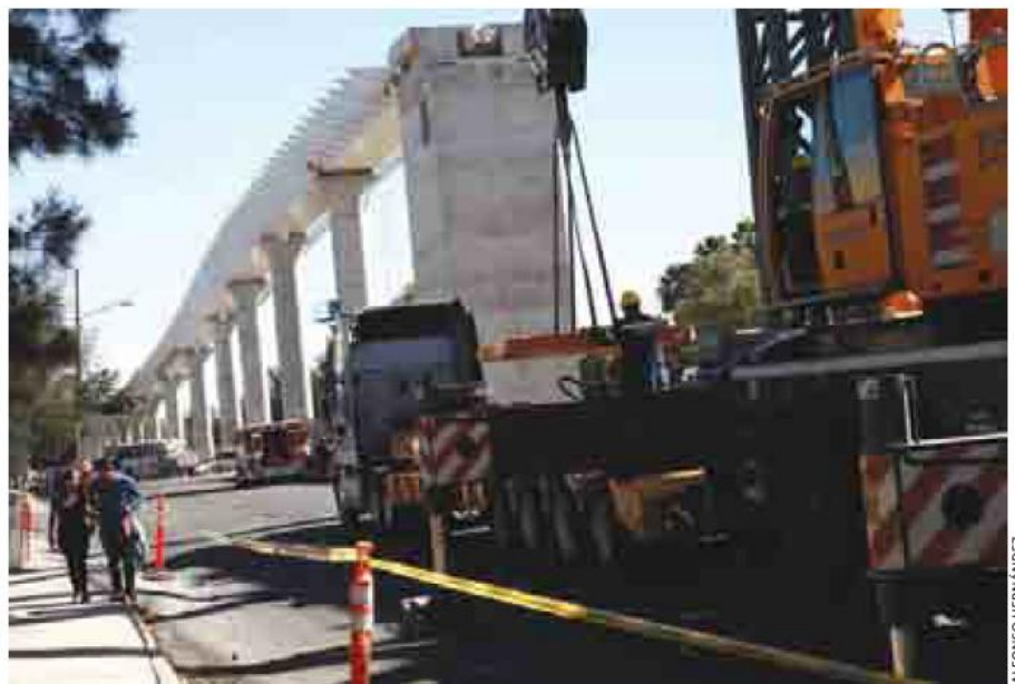
TRABAJOS. El avance de la obra es de 70 por ciento, asegura la SCT.
