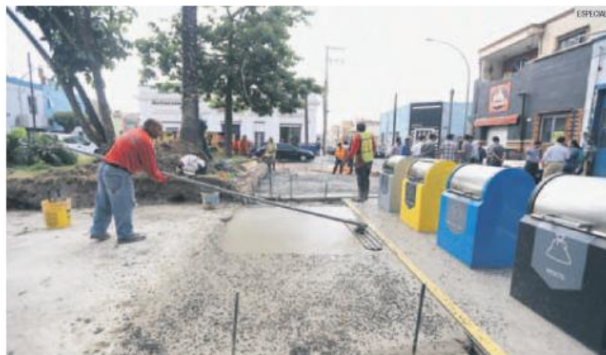
SOLICITUDES. Algunos vecinos pidieron adecuaciones de las obras a las autoridades tapatías.
