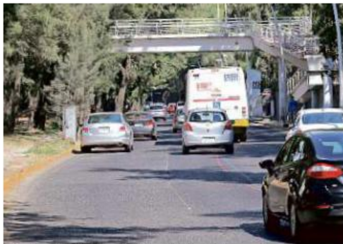
■ En Avenida Patria, a la altura de Los Colomos, tampoco se había colocado la señalética horizontal y vertical.
