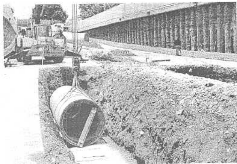
Ayer comenzaron a instalar las tuberías laterales de 1.5 metros de diámetro al colector del túnel de López Mateos y Las Rosas.
