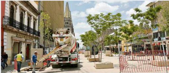
■ En otros tramos que ya deberían estar terminados, como en el cruce con Juan Manuel, los trabajadores aún realizaban adecuaciones ayer.
