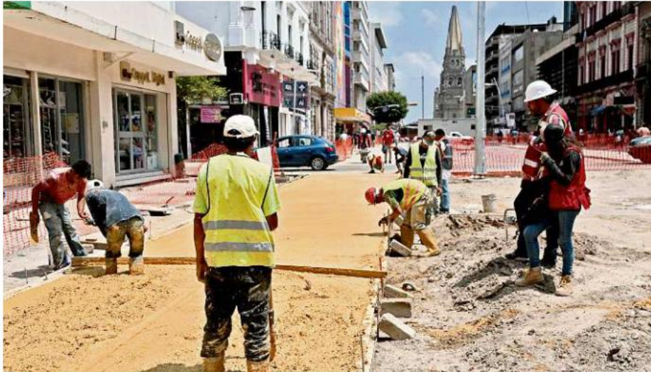
■ Los trabajos de la tercera etapa que se realizan desde Avenida Hidalgo hacia Avenida Revolución son los únicos que van en tiempo, pues según el contrato, deben concluirse en septiembre.
