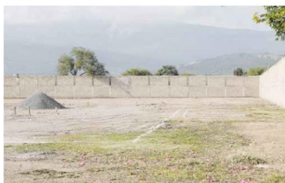
EXTENSIÓN. Las nuevas instalaciones se construyen en un área de mil 400 metros cuadrados.
