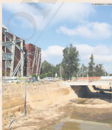
TÚNEL. El Viaducto Belenes en Zapopan tendrá una mayor inversión: 317 millones de pesos.
