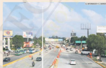
PERIFÉRICO NORTE. En este tramo hay un gran avance en la repavimentación. Se prevé terminar en noviembre.
