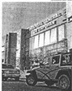
El derrumbe ocurrió en octubre
