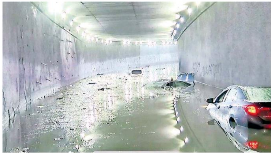
En el paso a desnivel de Colón al cruce Washington se inundó. FOTOS: CORTESÍA
