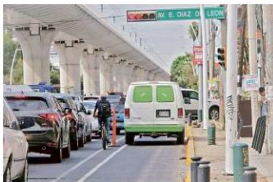
■ La ciclovía de Avenida Ávila Camacho es habitualmente invadida por autos; se colocarán aquí bolardos abatibles.
