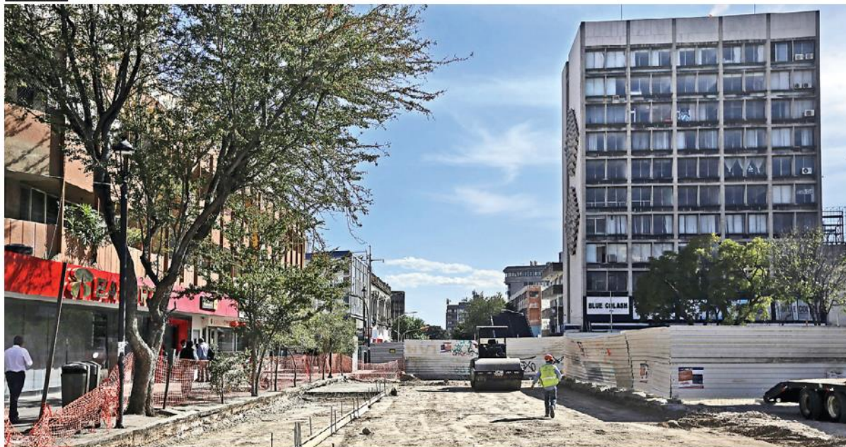
Así luce el Centro de Guadalajara; varias calles continúan cerradas por los trabajos de la obra. FERNANDO CARRANZA
