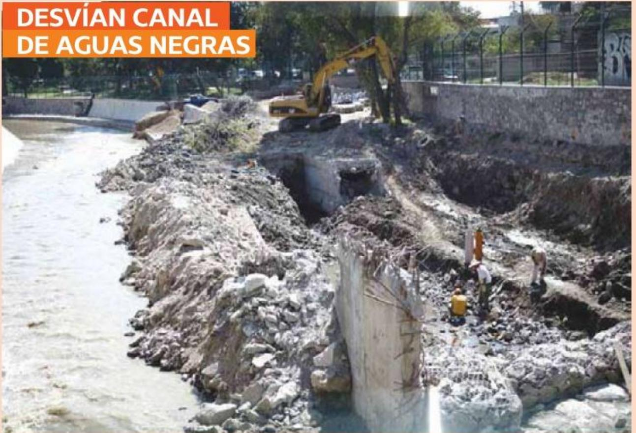
● **TRABAJOS.** A fines de 2016 y con una inversión de 350 millones de pesos, el Ayuntamiento de Guadalajara y el Sistema Intermunicipal de los Servicios de Agua Potable y Alcantarillado (Siapa) comenzó la instalación de un colector en la colonia Atemajac con el fin de separar las aguas negras de la potable y así mitigar las inundaciones durante el temporal; por ahora realizan la desviación del canal de aguas negras. Redacción
