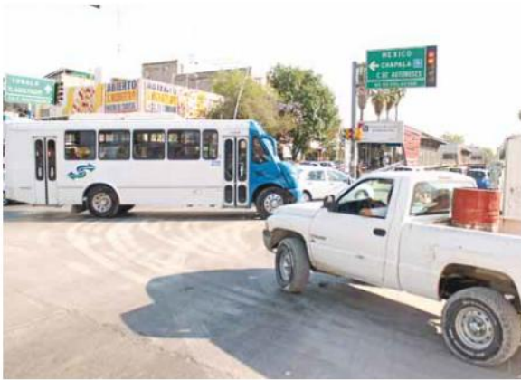
Automovilistas sufren por los bloqueos de las obras de la Línea 3 del tren. Francisco Rodríguez
