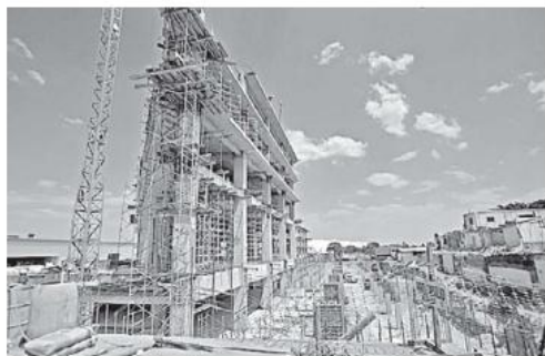
Serán seis pisos y dos sótanos para estacionamiento
