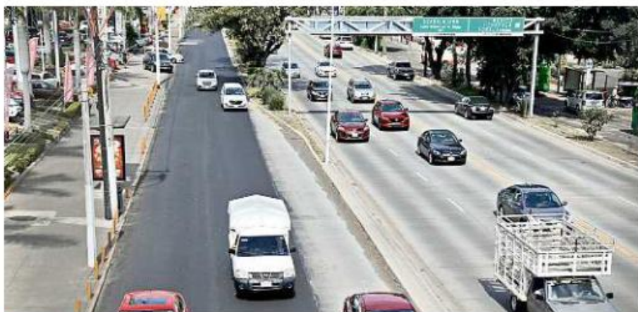
La repavimentación en la lateral poniente, a la altura de Avenida Conchita, ya está concluida, faltan labores de balizamiento; el tramo a intervenir es de Copérnico a Mariano Otero.
