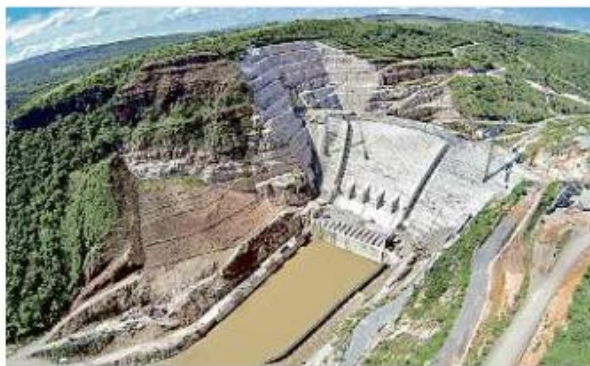
■ En agosto de 2016, Abengoa empezó a trabajar en un macrocircuito que forma parte del acueducto de la Presa El Zapotillo.
