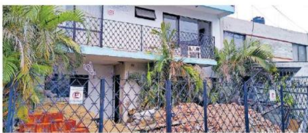
La construcción en cuestión e impugnada por los vecinos. ELIZABETH RÍOS.
