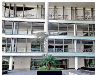
■ Casi siete años de su estreno, el tercer piso permanece en obra negra: ahí se construirán 5 juzgados, pero no hay fecha.
