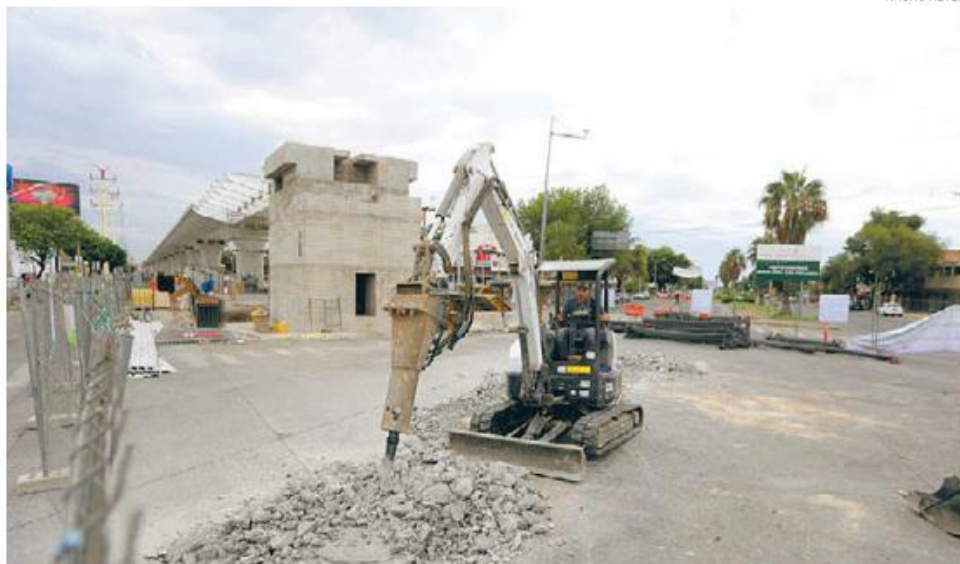
El cierre vial en la zona permanecerá durante seis meses debido a las obras de la Línea 3 del tren ligero
