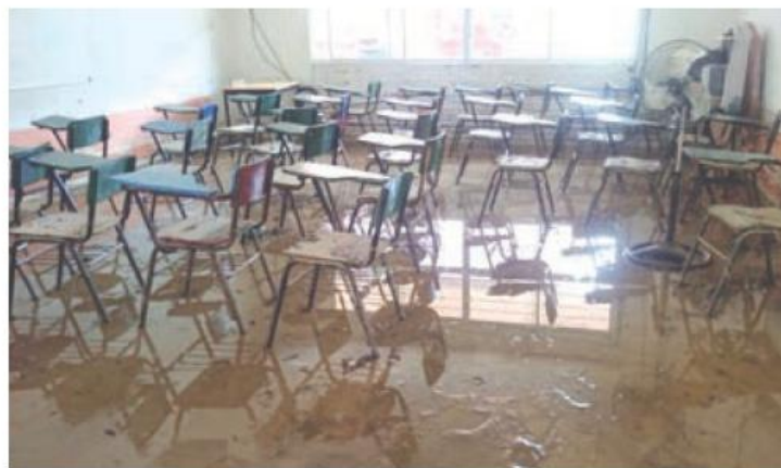
Algunos muestran daños en su interior y a otros no se le pueden instalar equipos de tecnología
