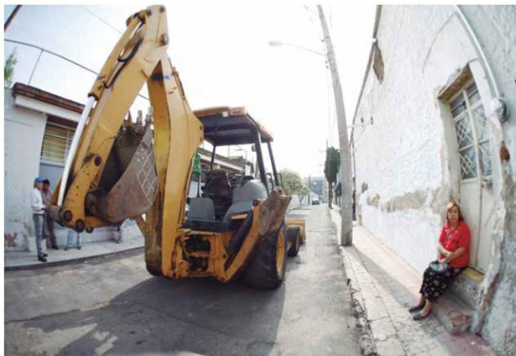
ARRANQUE. En Mezquitan se usará concreto hidráulico y asfalto.
