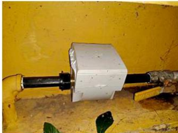
Los nuevos medidores del Siapa tienen un módulo de radiofrecuencia integrado.
