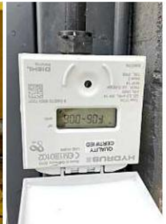
Los nuevos medidores del Siapa tienen un módulo de radiofrecuencia integrado.
