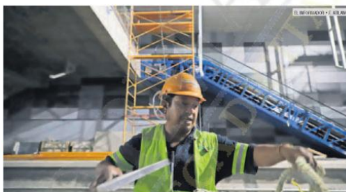
AVANCE. Los trabajos de la SCT se concentran en las estaciones subterráneas de la Línea 3.
