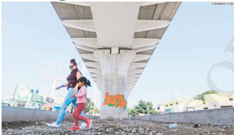
AJUSTE. Los neoprenos sirven como amortiguadores y evitan las vibraciones entre columnas y traveses de la Línea 3.
