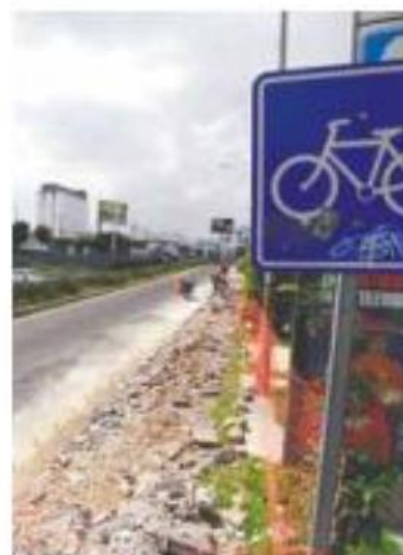
EL AÑO PASADO. Las obras de renovación iniciaron en octubre de 2019.
