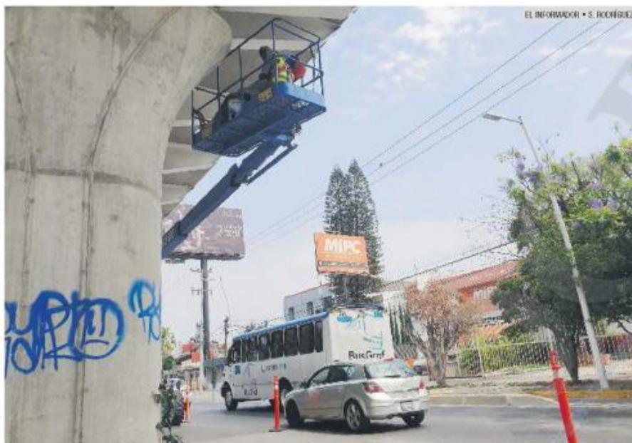
**NEOPRENOS.** Los soportes en las columnas del tren deben colocarse de día para evitar errores y omisiones.
