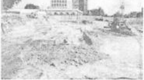
La excavación en la zona es evidente, ante unas obras que parecen detenidas el gobernador se pasó para dar su visto bueno.
