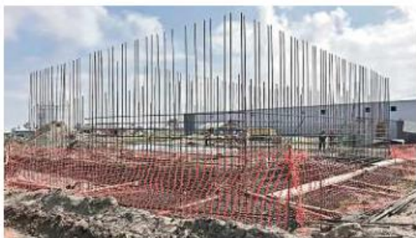
■ El Municipio mostró los avances en la planta potabilizadora de El Zapote, que surtirá a Agaves y Silos, entre otros.
