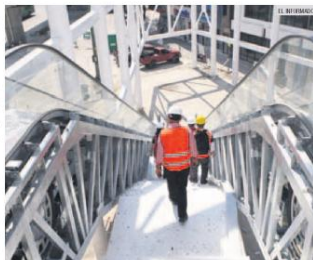
PROYECTO. El Gobierno de Jalisco prevé que en noviembre opere el viaducto de la Línea 3 del Tren Ligero en Tlaquepaque.
