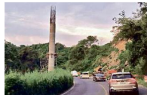
La altura del poblado de San Quintín, Nayarit, se aprecian las estructuras de la nueva carretera, pero aún falta mucho.
