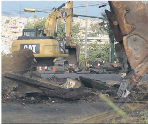
TRABAJOS. Ayer inició la primera de tres etapas de labores para la creación de este transporte masivo, el cual tendrá 41.5 kilómetros de longitud y 46 estaciones. Irá desde la Avenida Malecón hasta la Carretera a Chapala.
