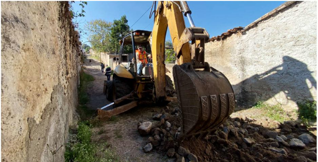
Ayer iniciaron las obras de rehabilitación. ESPECIAL
