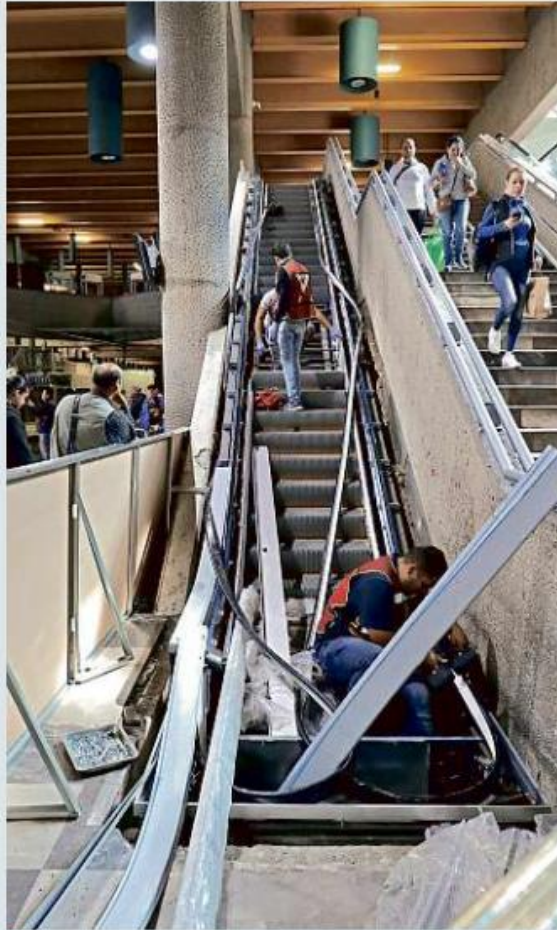
Personal de Siteur trabaja en la instalación de las nuevas escaleras eléctricas en la estación Juárez del Tren Ligero.
