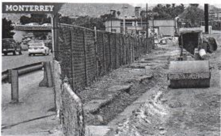
MALLAS. En la construcción de la Línea 3 de Metrorrey, las empresas utilizan malla ciclónica recubierta para resguardar la obra.
