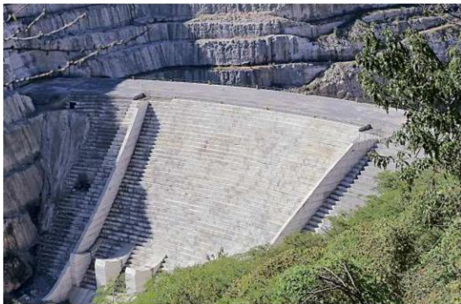
■ El Ejecutivo Estatal decidió que la cortina de la presa alcance los 105 metros de altura.
