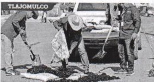
Una de las mezclas usadas para tapan los agujeros se lleva en costales y el aplanado se realiza con palas.
