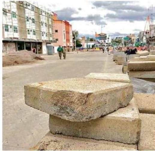
El adoquín aún no ha sido colocado y ya hay piezas dañadas.
