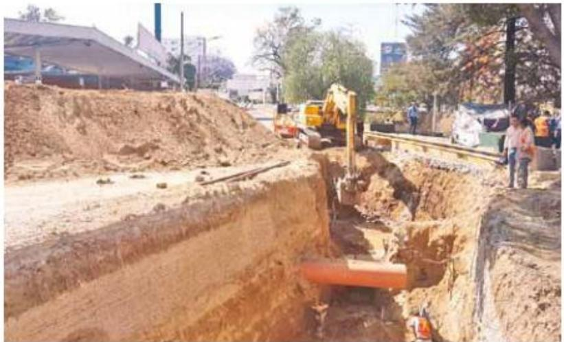
Instalan tuberías de acero cuya longitud alcanza los 40 metros. Foto: Cortesía
