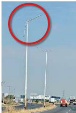
■ En varios tramos no hay luminarias y los postes están dañados.
