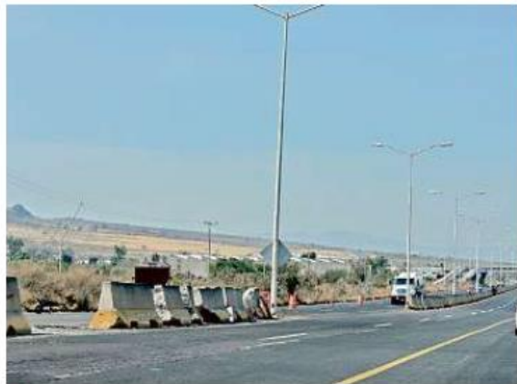
■ La SIOP inició la rehabilitación del asfalto de un tramo de esa vialidad a la altura de la Carretera Libre a Zapotlanejo.
