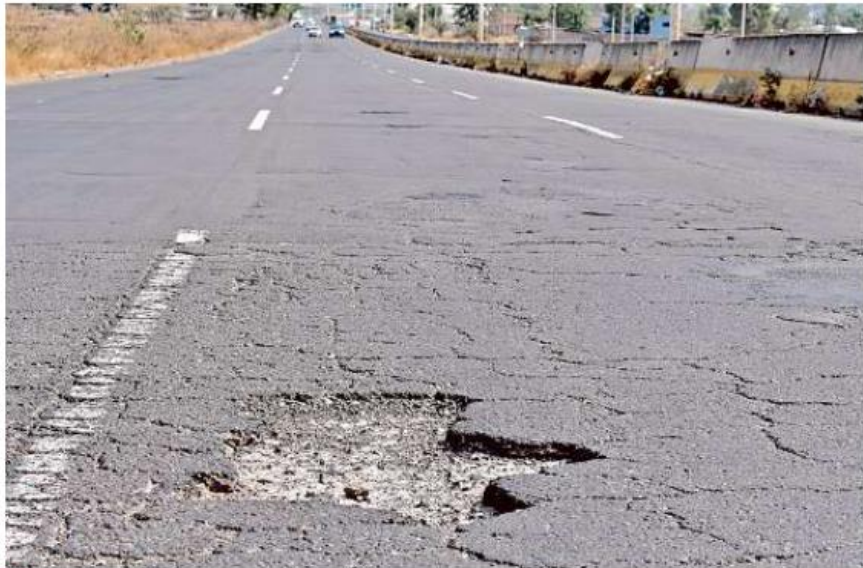
■ La carpeta asfáltica tiene varios tramos dañados y con baches.
