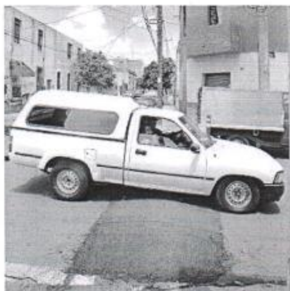
Siapa y Siteur colocaron la infraestructura.
