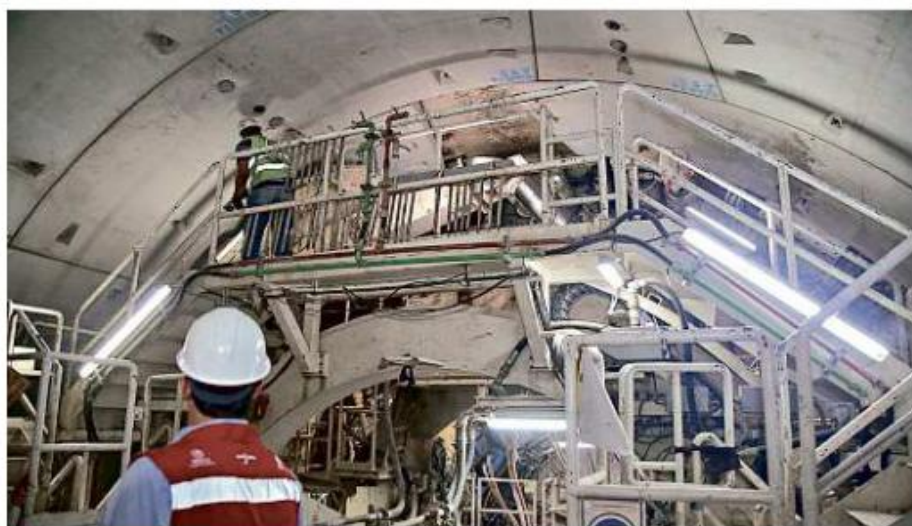
La tuneladora se encuentra en Av. Revolución, entre Anáhuac y 20 de Noviembre, según Siteur.
