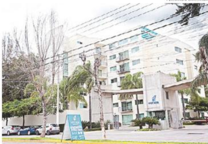
El complejo de edificios en la ex villa maicera
