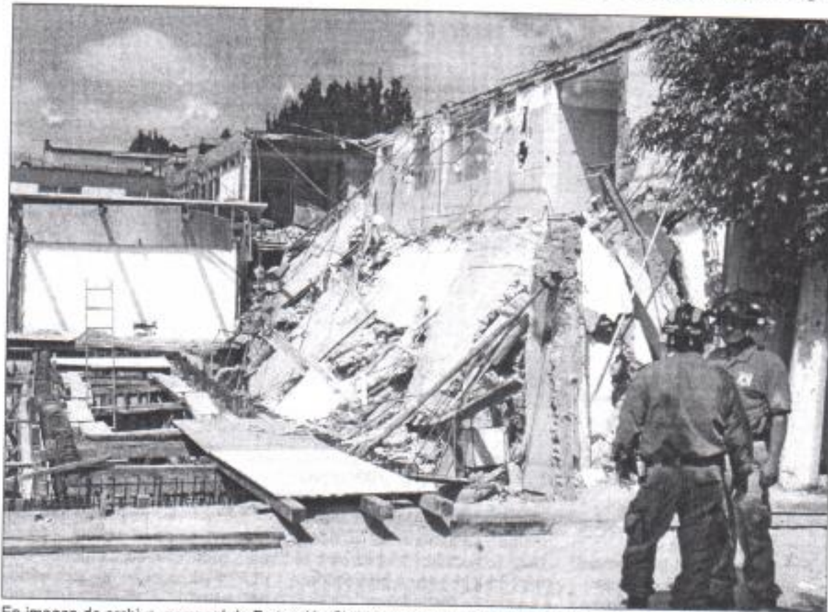
En imagen de archivo, personal de Protección Civil inspecciona la zona del derrumbe ■ Foto La Jornada Jalisco
