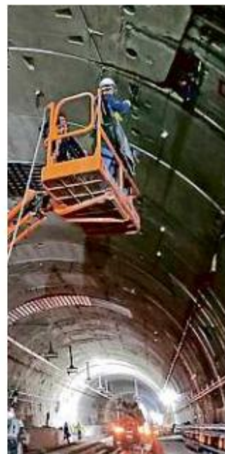
En junio se inyectó espuma en varios anillos del túnel.
