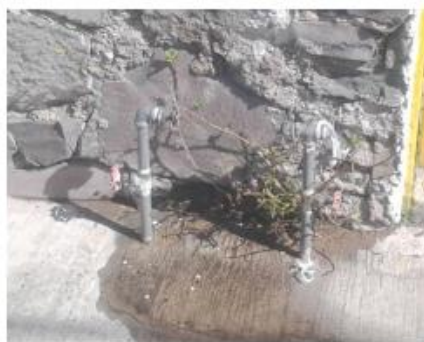
Amanecieron solamente las conexiones estilando agua al haber retirado los medidores.
