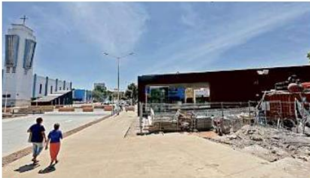
■ En la estación Plaza de la Bandera de la L3 del Tren Ligero todavía faltan muchos detalles en el entorno.
