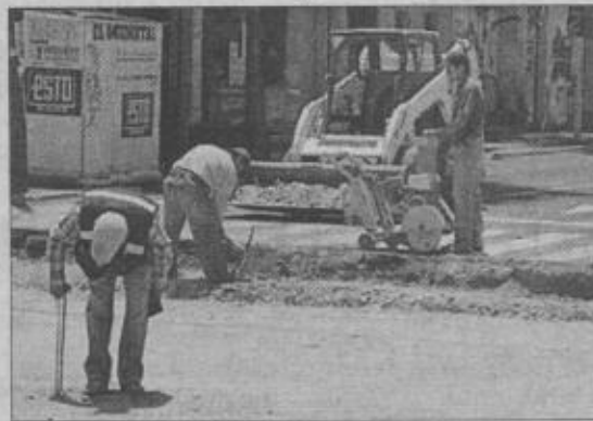
» EL PROCESO de pavimentación se realiza en calles y avenidas principales de la ciudad.
