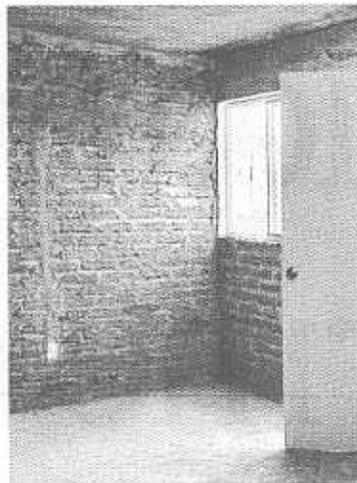
► La deficiente construcción se puede ver en la base para el medidor de la luz, que se mueve con facilidad y en su única habitación, que no tiene ni enjarre.
