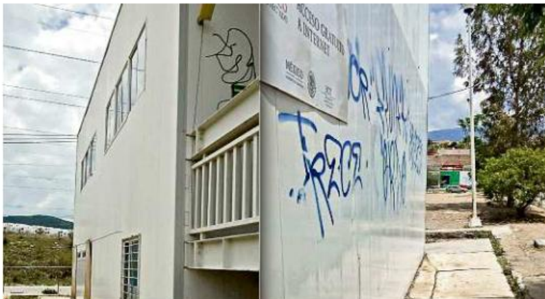
■ Según colonos, en uno de los planteles de la zona, la Primaria Francisco Rojas González, en Lomas del Sur, ha habido hundimientos en un edificio, por lo que no se puede usar.
