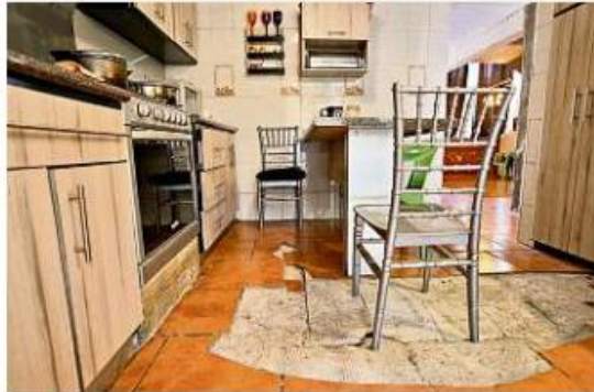
■ En la casa de Leticia Barajas, en Calle Santa Mónica, los muebles y el piso han resultado dañados desde junio.
