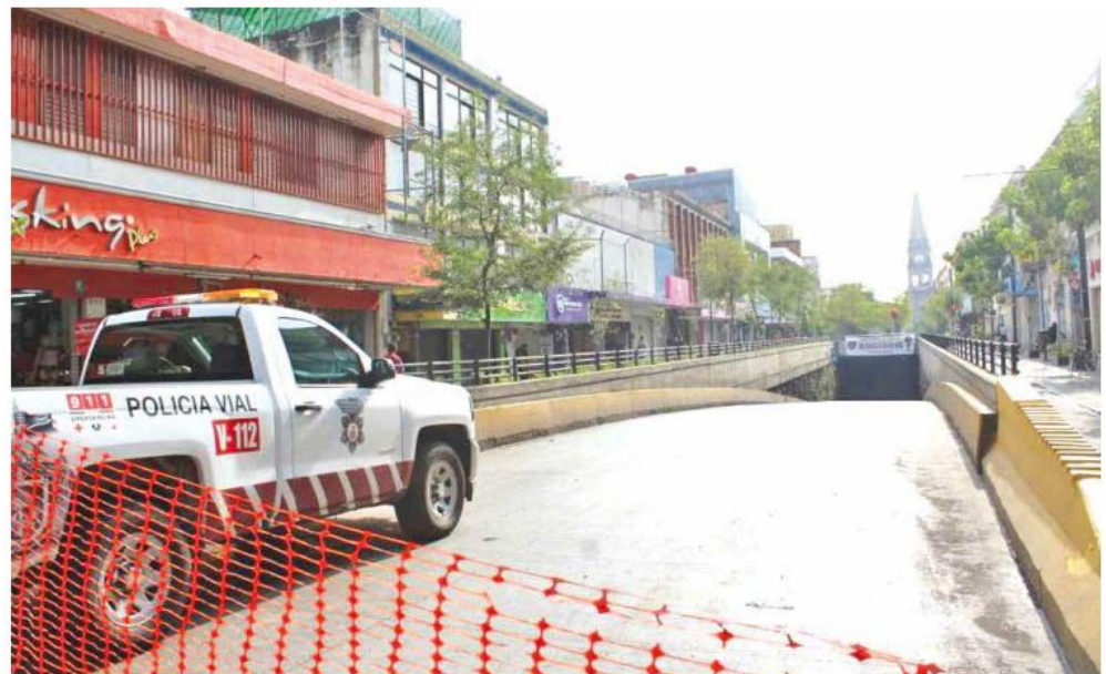
Así lució el túnel de la avenida Hidalgo. Aurelio Magaña
