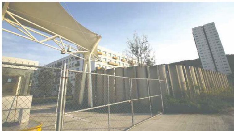
PERJUDICIAL. Vale la pena tumbar la infraestructura para proteger la zona, aseguran.
