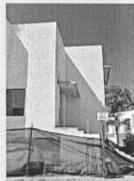
■ Esta casa se construye en un predio que compró Vega Pámanes en 2004.
