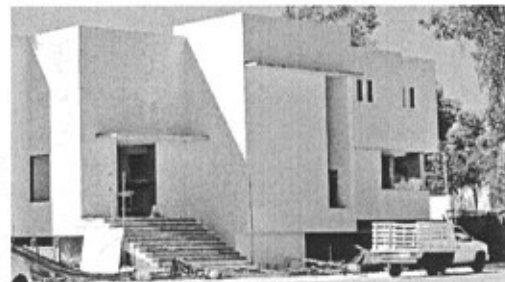
En el coto Rinconada del Bosque se vio que está en construcción la casa de Vega Pámanes.
