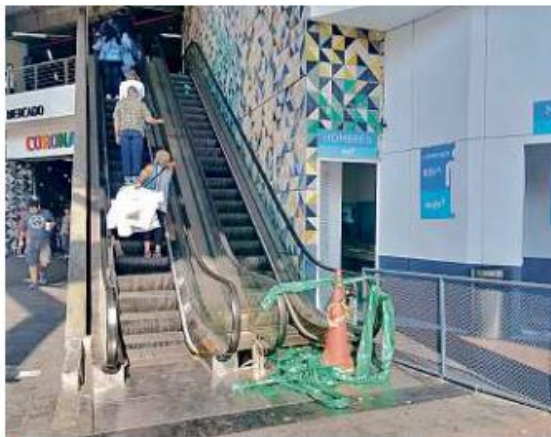
■ Ayer a las 10:00 horas así se encontraban las escaleras.
