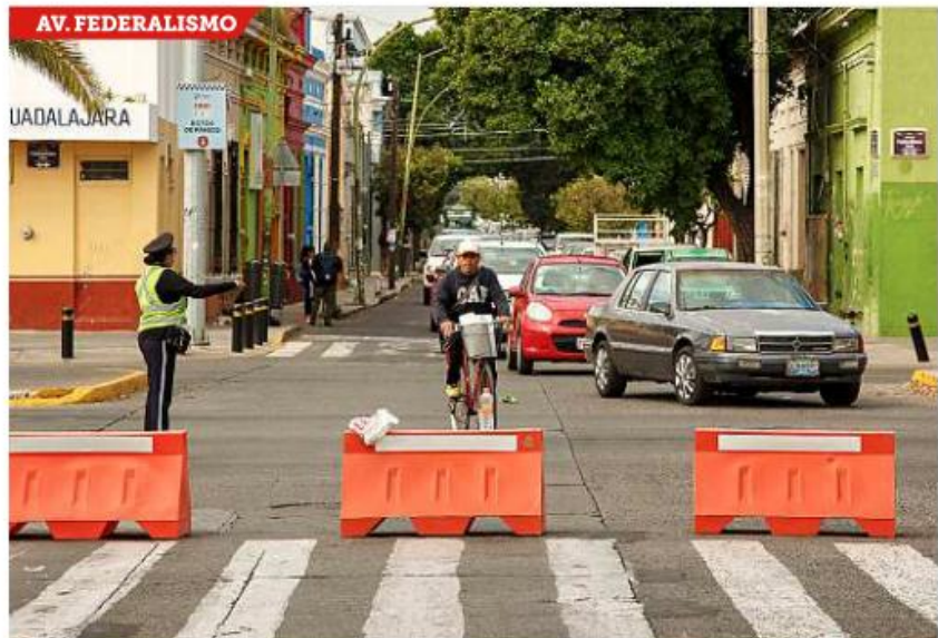
En la zona de obra hay agentes viales, pero no mantas que avisen del cierre.
