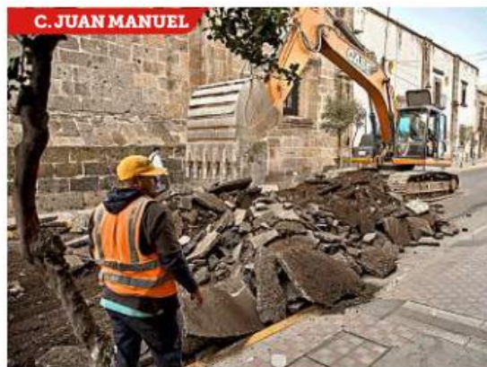
Desde ayer se comenzó a levantar pavimento para colocar concreto hidráulico y cambiar redes hidrosanitarias.
