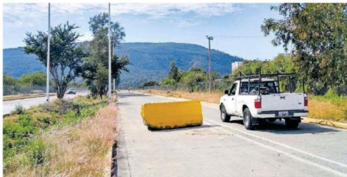
Muros de concreto bloquean los carriles del circuito. ELIZABETH RÍOS.
