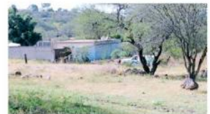
Dicha fosa está ubicada aproximadamente a 80 metros, de la primer fosa.
