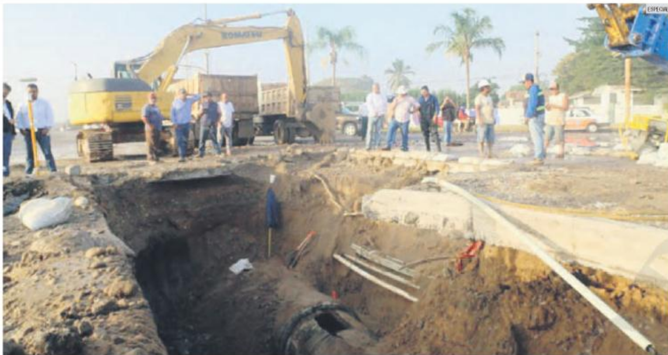
TRABAJOS. Además de las labores de limpieza, autoridades realizan la reparación del colector donde se registró la ruptura.
